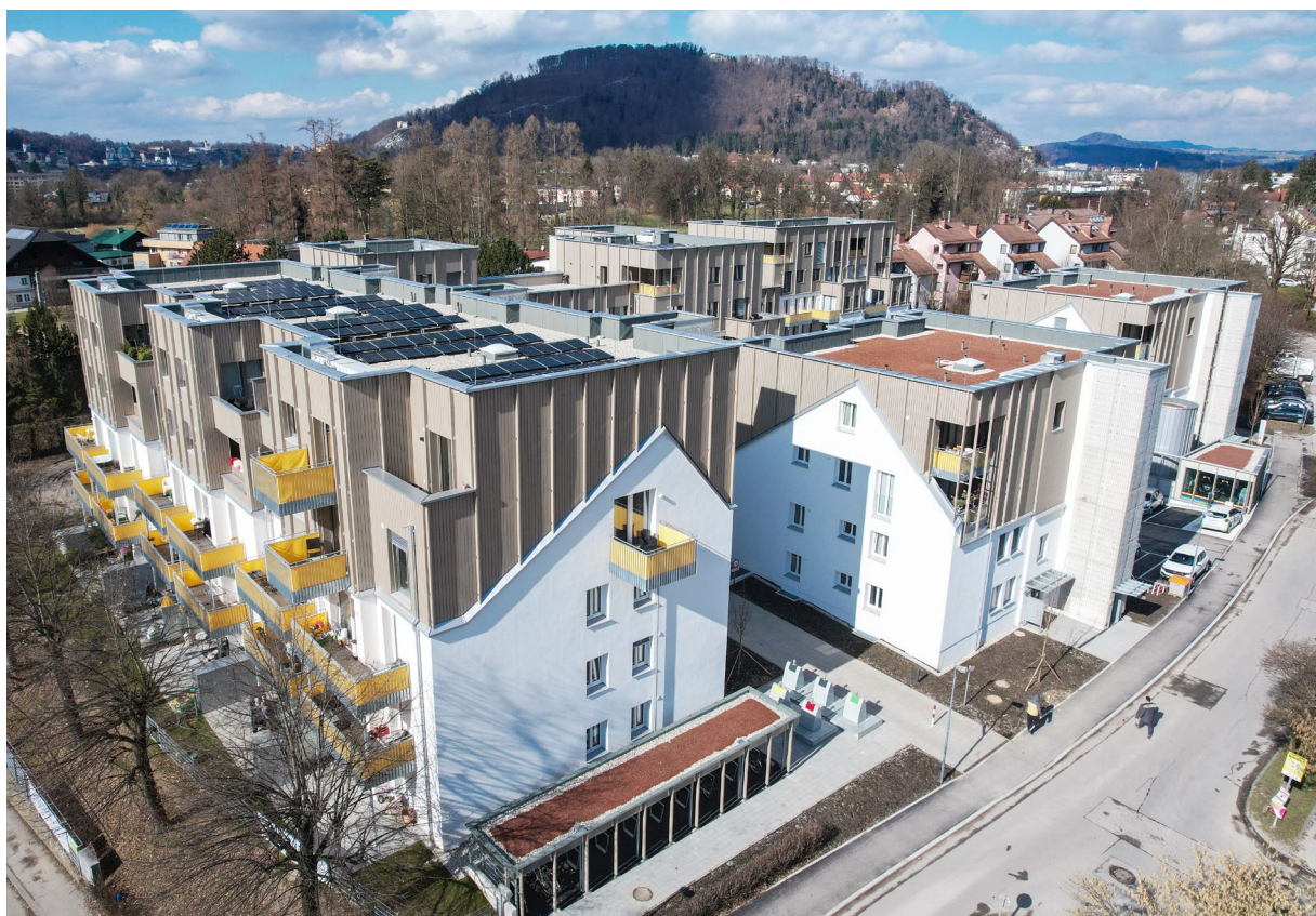
Abbildung 22: Projekt Wir InHAUSer, Fertigstellungsgrad 95%, alte und neue Haushalte bereits eingezogen
