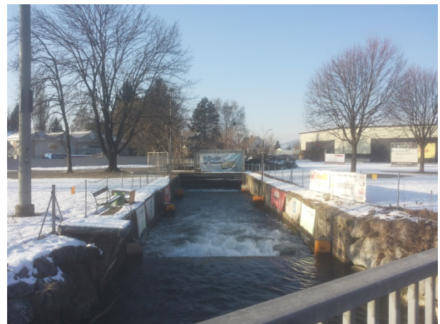
Abbildung 1: Blick auf den Mühlgang. Freizeitnutzung bei der „Mugl Wave“. Bildquelle: AEE INTEC
