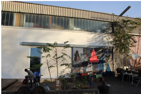
Abbildung 10: Das Künstlerkollektiv Schaumbad hat seinen Teil der Außenfassade quasi eigenhändig in Kooperation mit der Ortweinschule energetisch und optisch verbessert. Bildquelle: AEE INTEC
