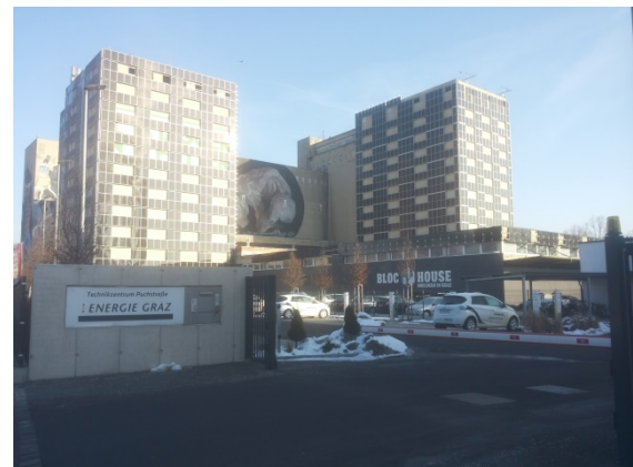
Abbildung 5: Auf den Gebäuden der Taggermühle sind PV Module montiert. Daneben befindet sich das Bloc House. Bildquelle: AEE INTEC
