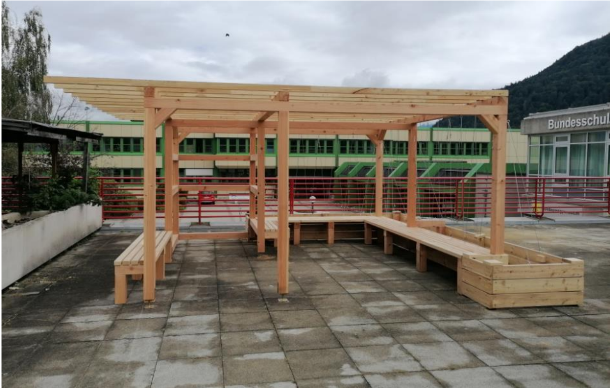
Abbildung 3: fertige Pergola Wörgl
