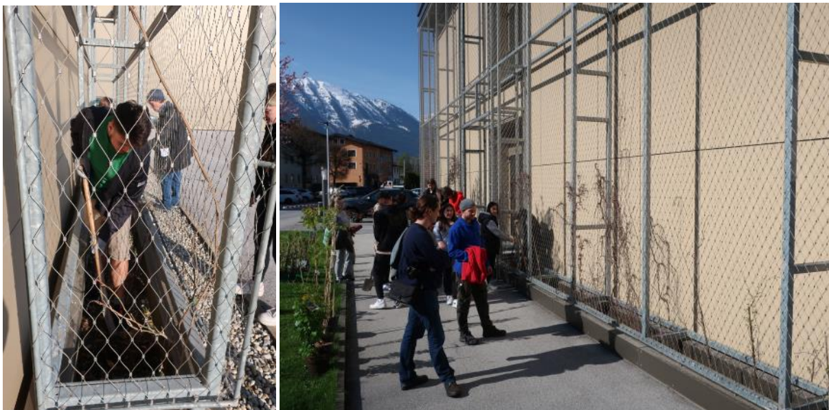
Abbildung 14: Pflanzarbeiten an den Fassaden St. Johann im Pongau
