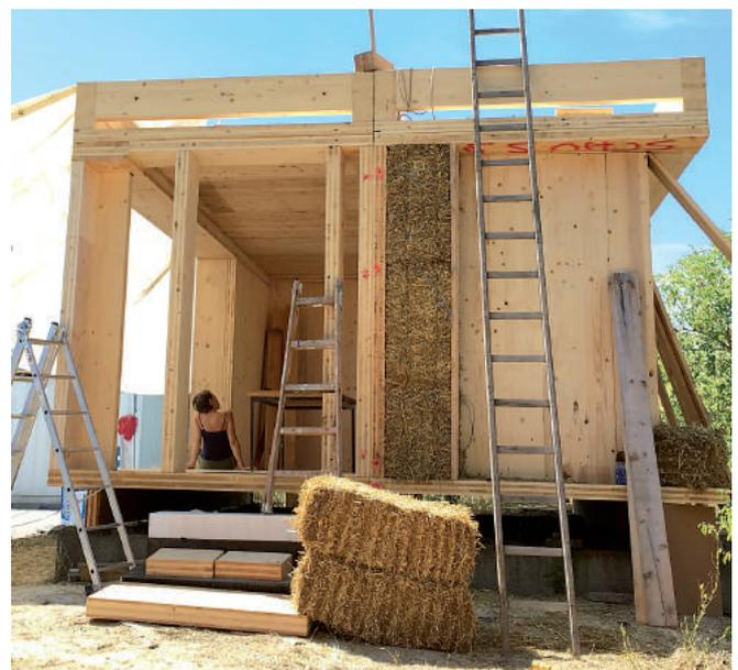
Die eingebauten Strohballen und winddichten Faserplatten dienen als Dämmstoffe im Selbstbauhaus von Baus!.
