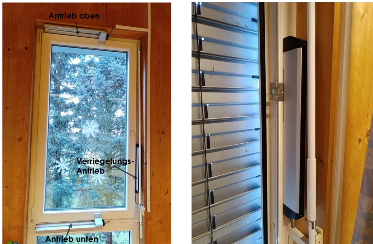
Abbildung 43: Stellantriebe am Fenster, sowie Verriegelungsantrieb (rechts)
