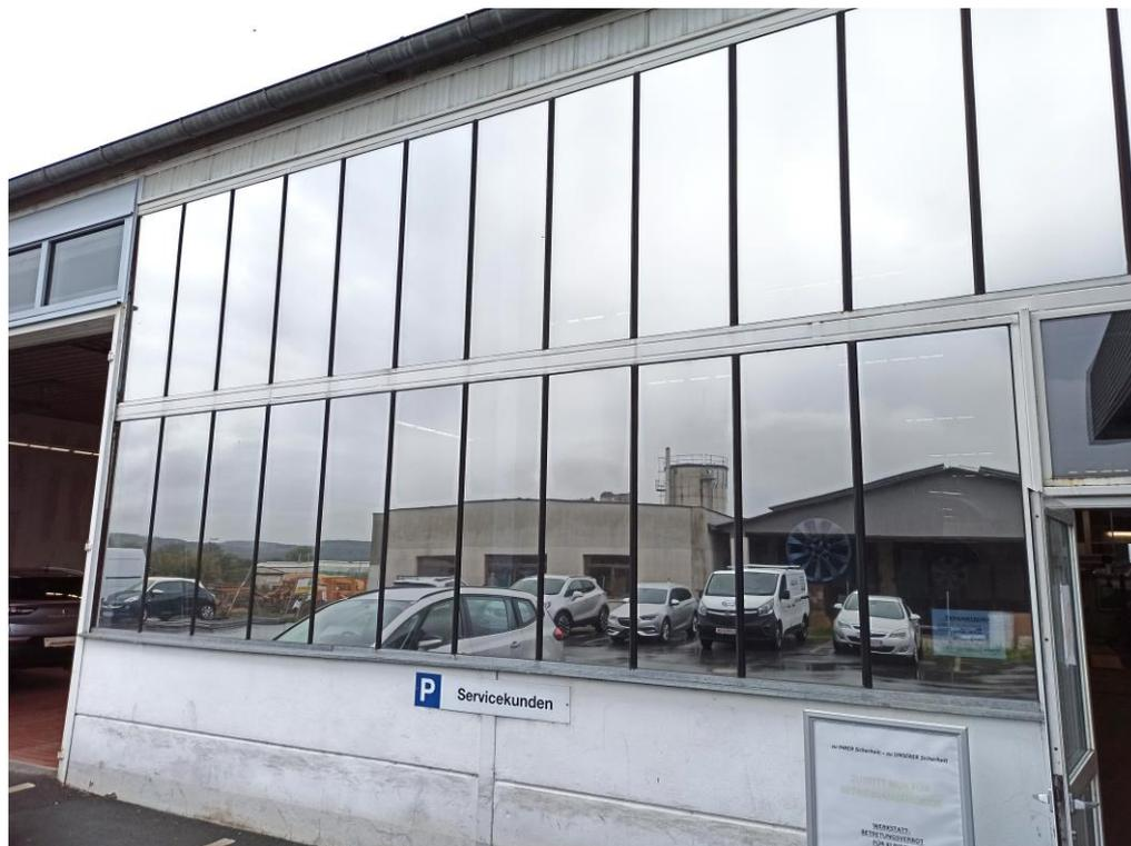
**Abbildung 19: Südliche Fensterfront der Werkstatt nach der Montage der Sonnenschutzfolien**
