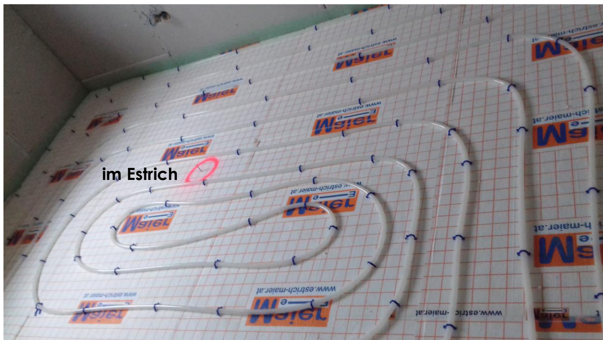
Abbildung 24: Temperatursensor wurde für das Monitoring im Estrich verlegt
