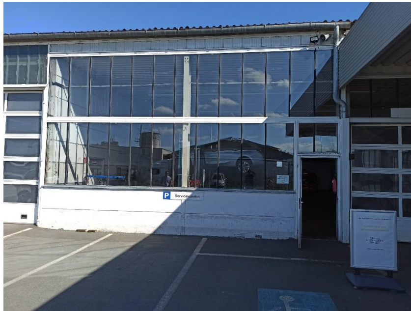
Abbildung 10: Südliche Fensterfront der Werkstatt vor der Montage
