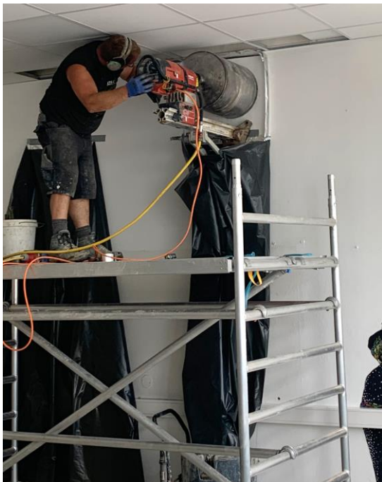
Abbildung 36: Durchführen der Kernbohrung für die Lüftungskanäle nach außen; Fertig montiertes Lüftungsgerät
