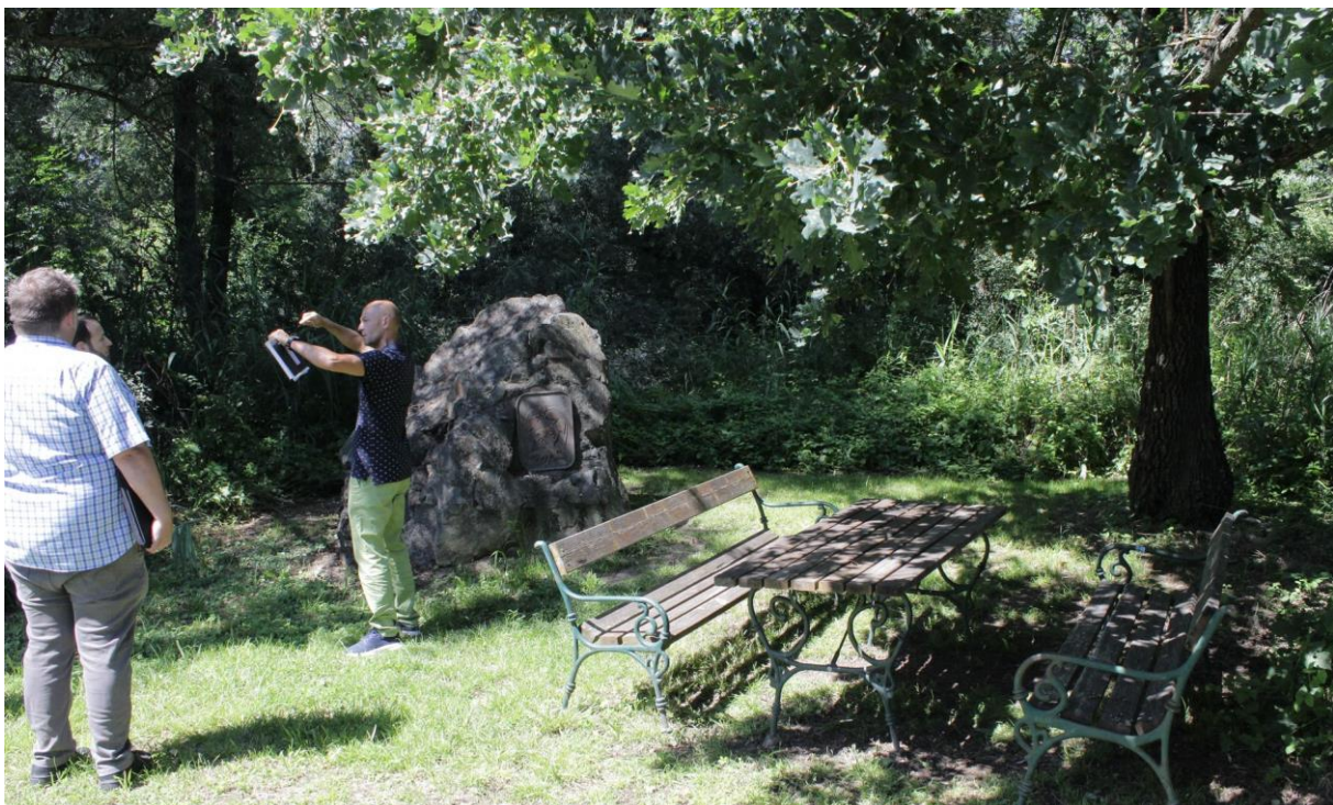
Abbildung 38: Bereich der Outdoorklasse vor den Umbauarbeiten, stark verwildert
