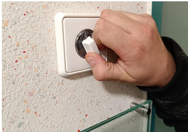
Abbildung 29: Schalter für Wartungs- und Reinigungsarbeiten, außerhalb der Reichweite von Kindern
