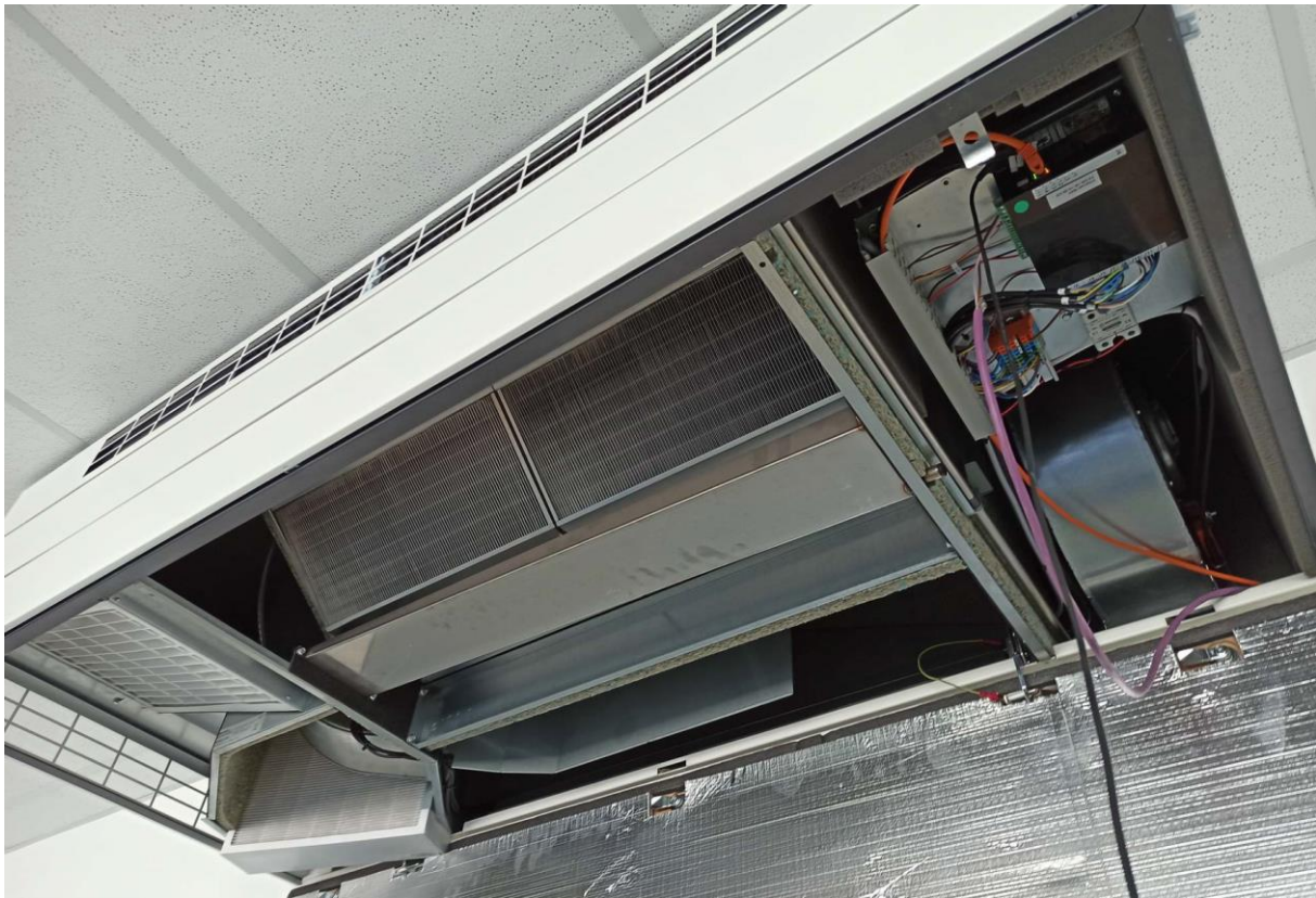
Abbildung 37: Geöffnetes Lüftungsgerät AM800 mit Filter, Ventilatoren, Wärmerückgewinnung und Steuerung
