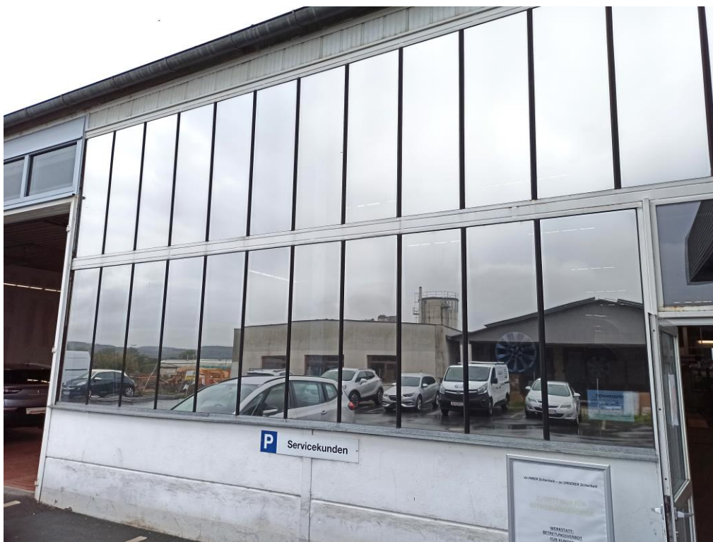
Abbildung 11: Südliche Fensterfront der Werkstatt nach der Montage der Sonnenschutzfolien
