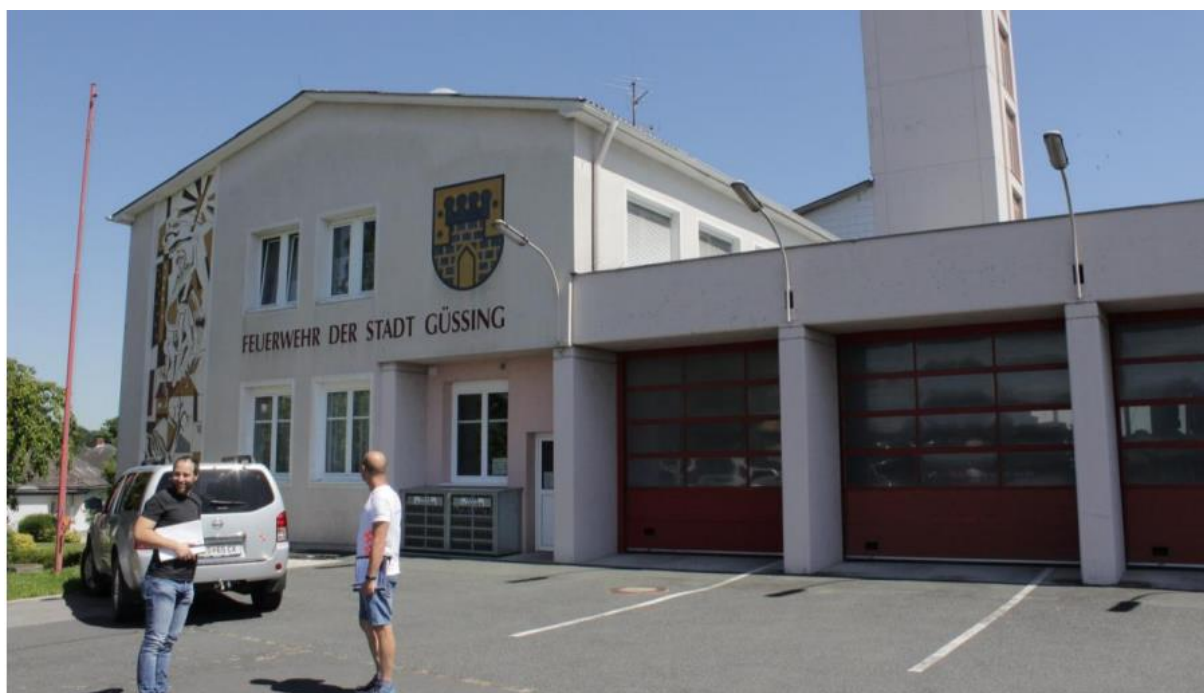
Abbildung 41: Nordwestseitige Fassade des Feuerwehrhauses 11
