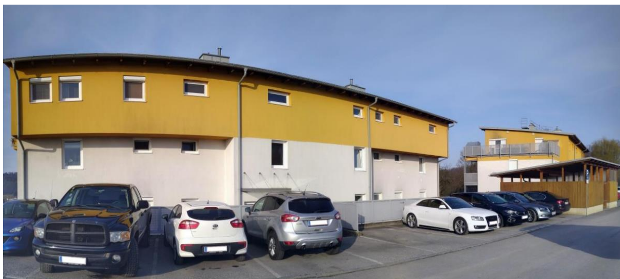
Abbildung 20: Wohnhausanlage Krottendorf – Nordostansicht 6
