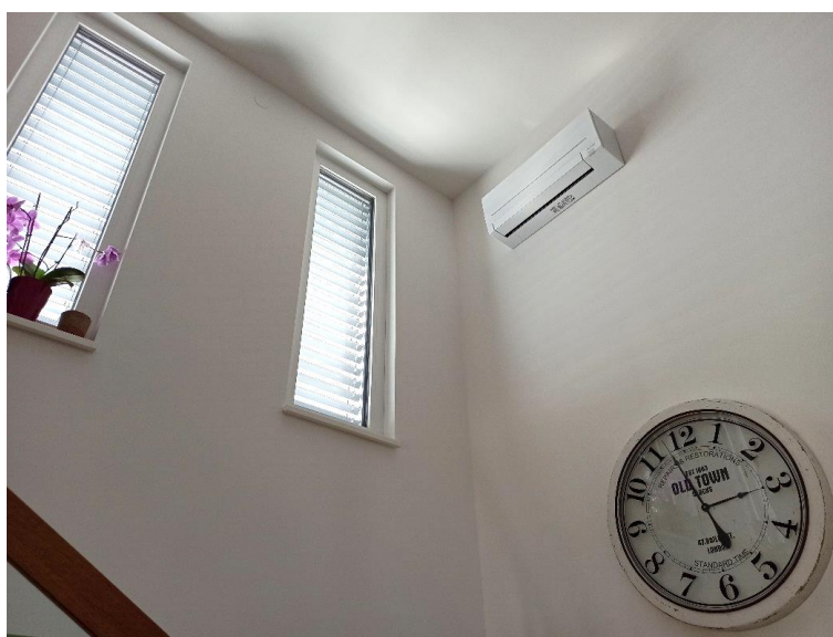
Abbildung 18: Klimasplitgerät im EFH Doczekal zur zentralen Kühlung des Wohnbereichs wurde 2021 installiert
