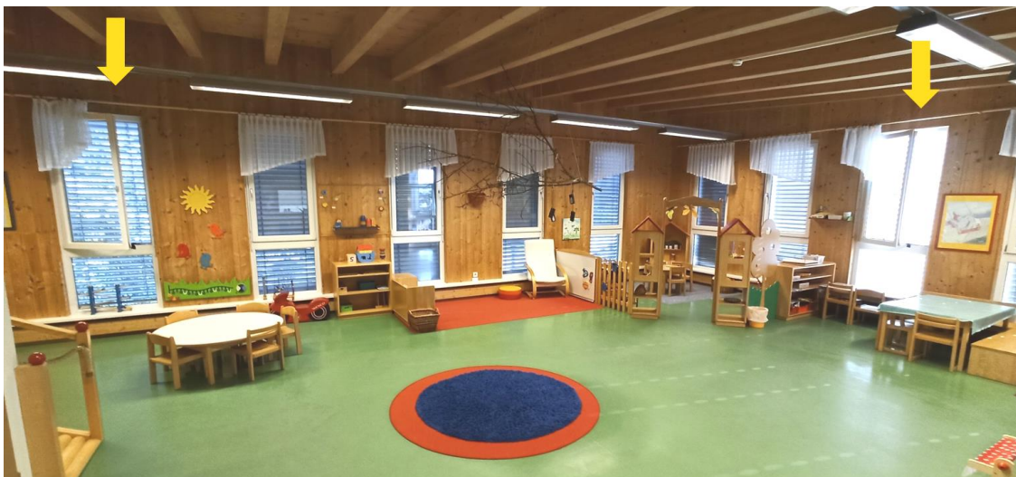
Abbildung 27: Situierung der Fenster mit den Stellantrieben zur Querlüftung je Raum
