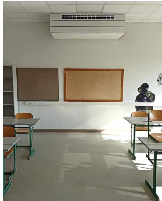
Abbildung 36: Durchführen der Kernbohrung für die Lüftungskanäle nach außen; Fertig montiertes Lüftungsgerät
