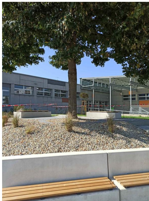
Abbildung 40: Beschattete Sitzplätze vor dem Haupteingang wurden errichtet
