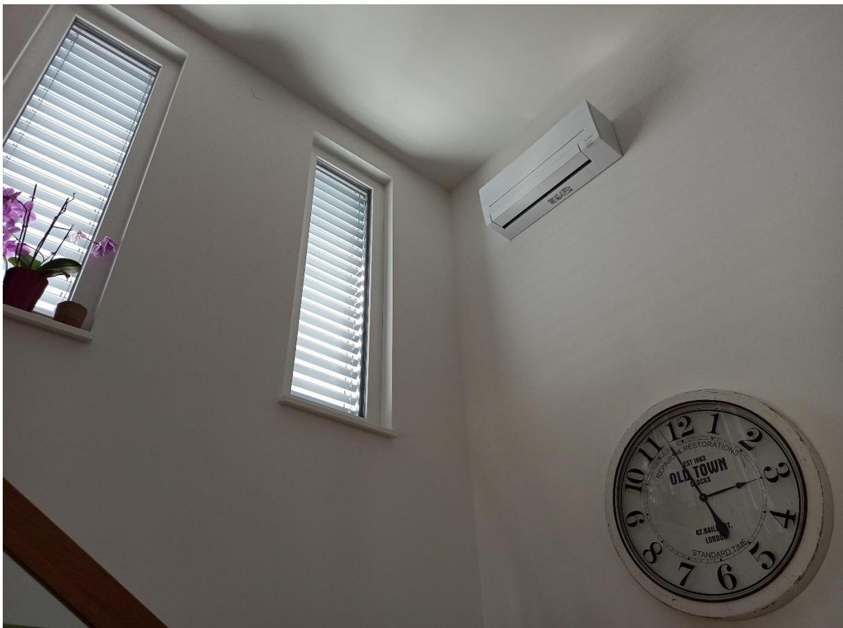
Abbildung 12: Einfamilienhaus Doczekal: Klimagerät in Verbindung mit einer PV-Anlage
