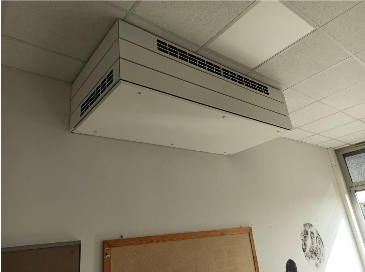
Abbildung 20: Dezentrales Lüftungsgerät im BORG Güssing
