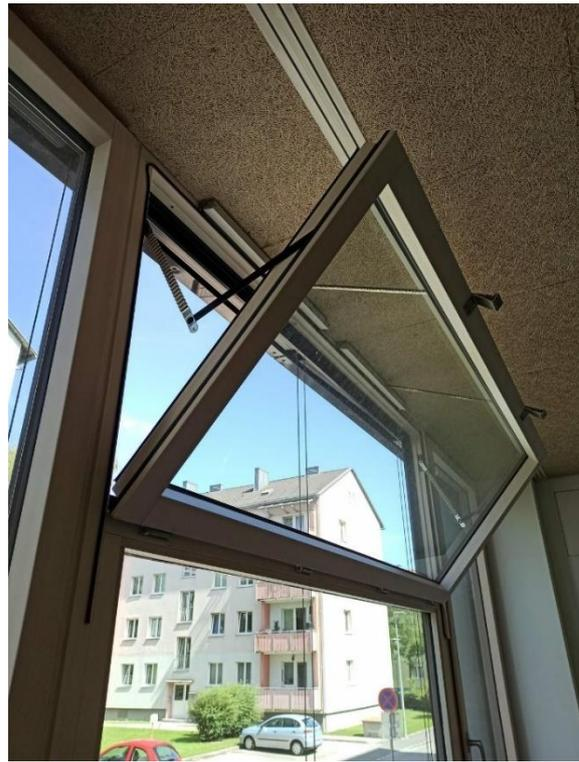
Abbildung 82: Automatischer Fensterantrieb
