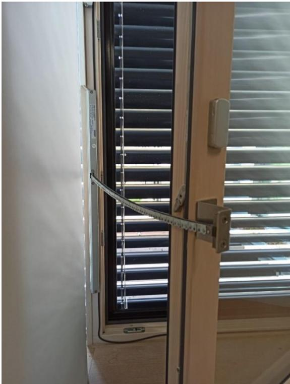
Abbildung 81: Automatischer Fensterantrieb
