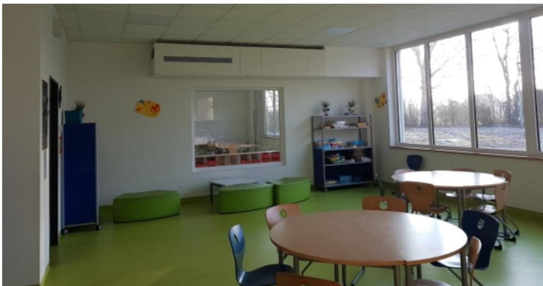
Abbildung 86: Dezentrales Lüftungsgerät für eine Klasse<sup>34</sup>
