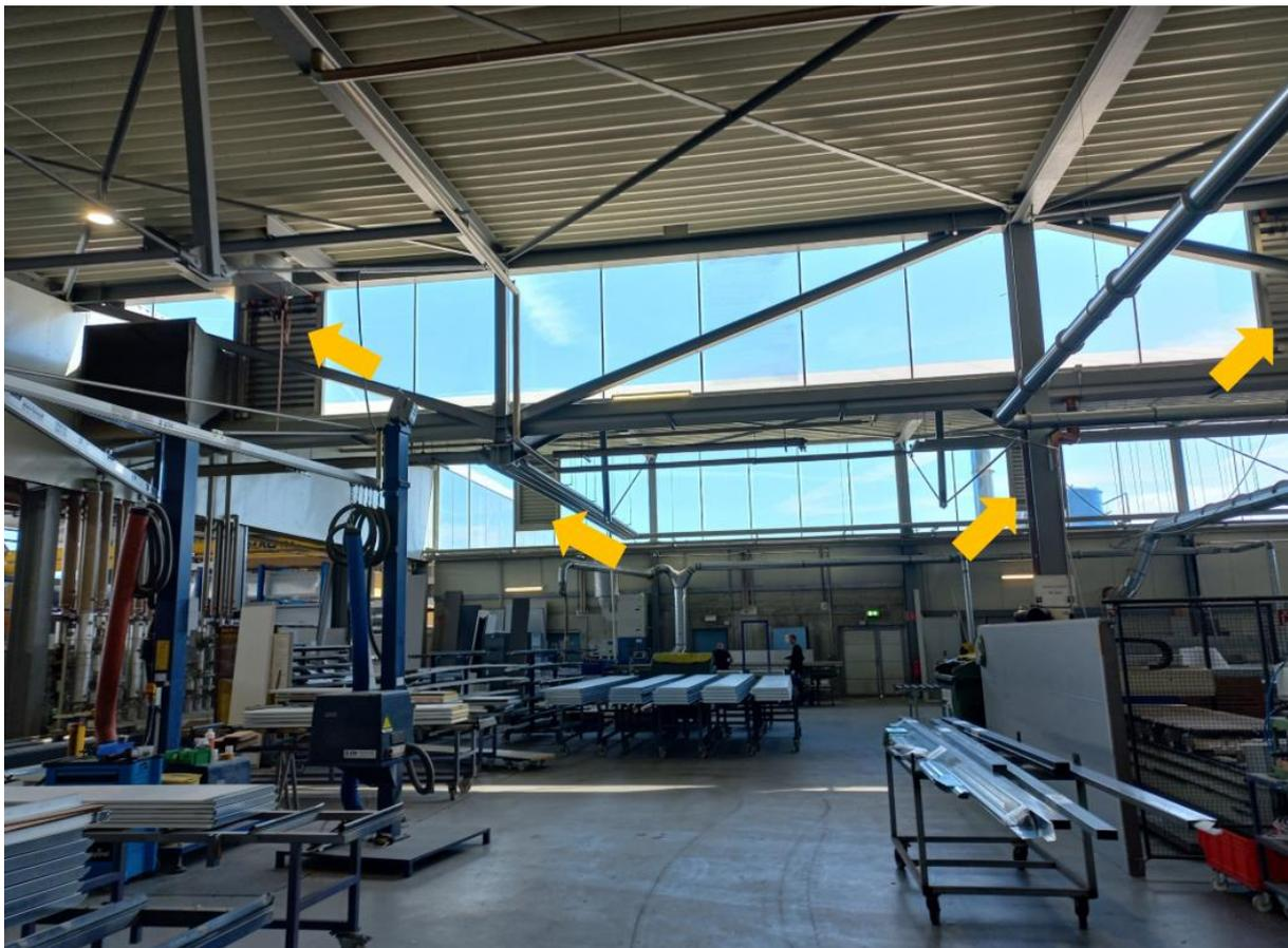
**Abbildung 21: Produktionshalle der Fa. Guttomat mit der Fensterfront, Pfeile markieren die Klappen der Brandrauchentlüftungsanlage**
