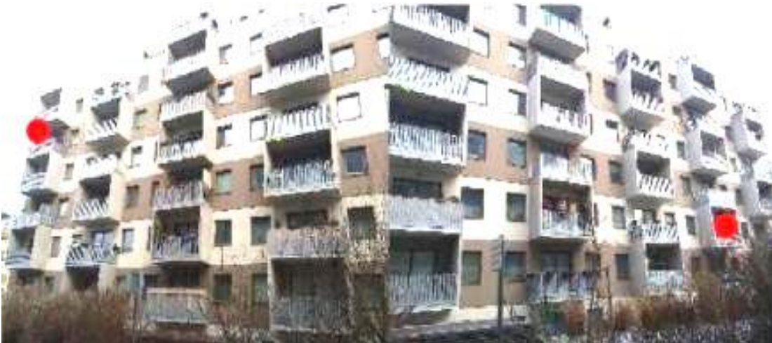
Abbildung 37: Messstellen an das Passivhaus Aspangstraße 6
