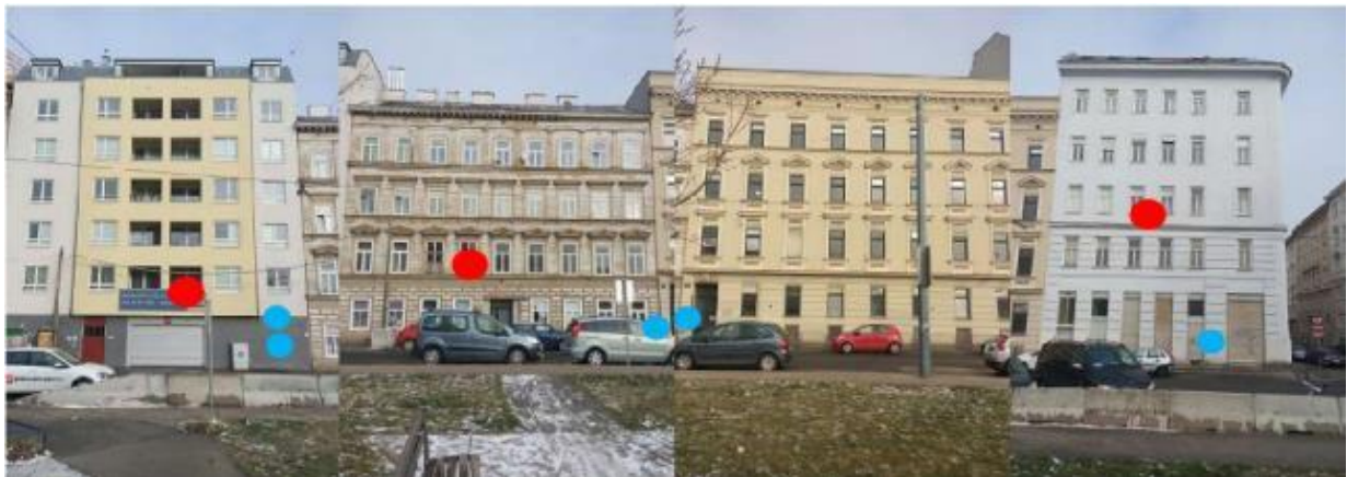
Abbildung 34: Messstellen an Altbau Gebäuden und Gebäuden aus den 70er und 80er Jahren (1)
