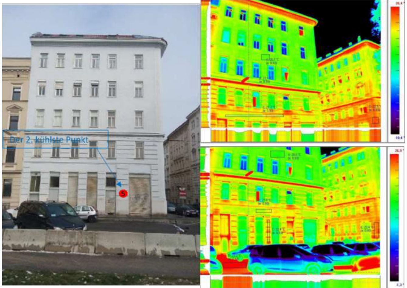
Abbildung 46: Gründerzeithaus Aspangstraße Nr.35; Vergleich der Aufnahmen mit einer Foto- und Wärmebildkamera
