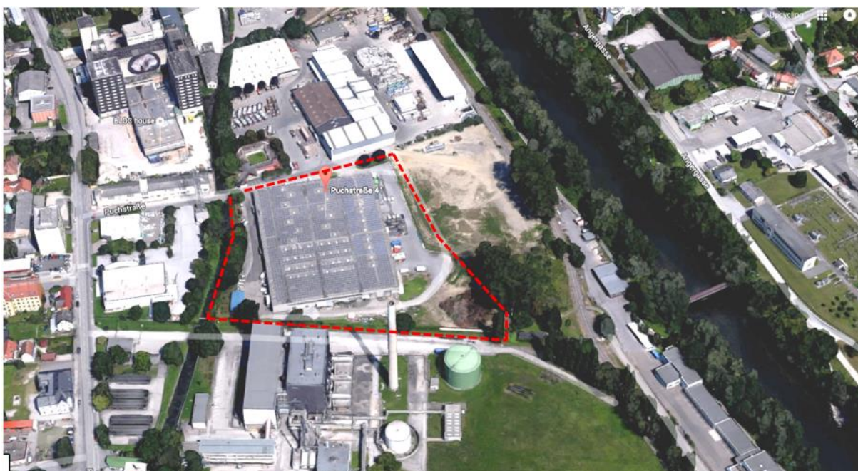
Abbildung 32 Luftbild der Industriehalle Puchstraße 41 – Quelle: google maps / bearbeitet
