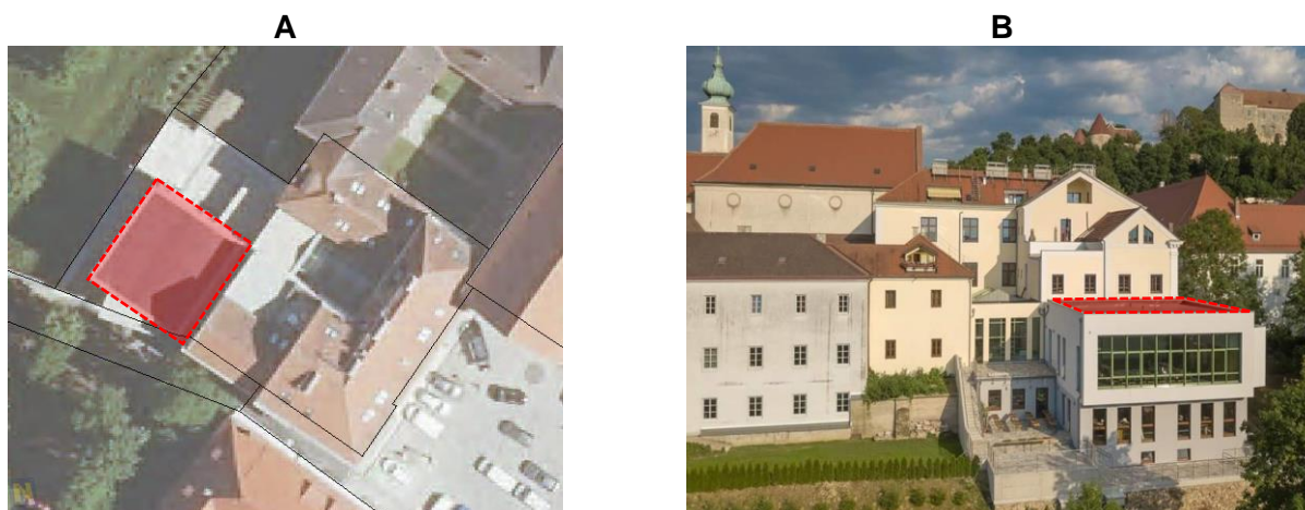
Abb. 55: Luftbild des Gebäudekomplexes vom Rathaus Neulengbach 101 (a) und Ansicht von Westen 102 (b)
