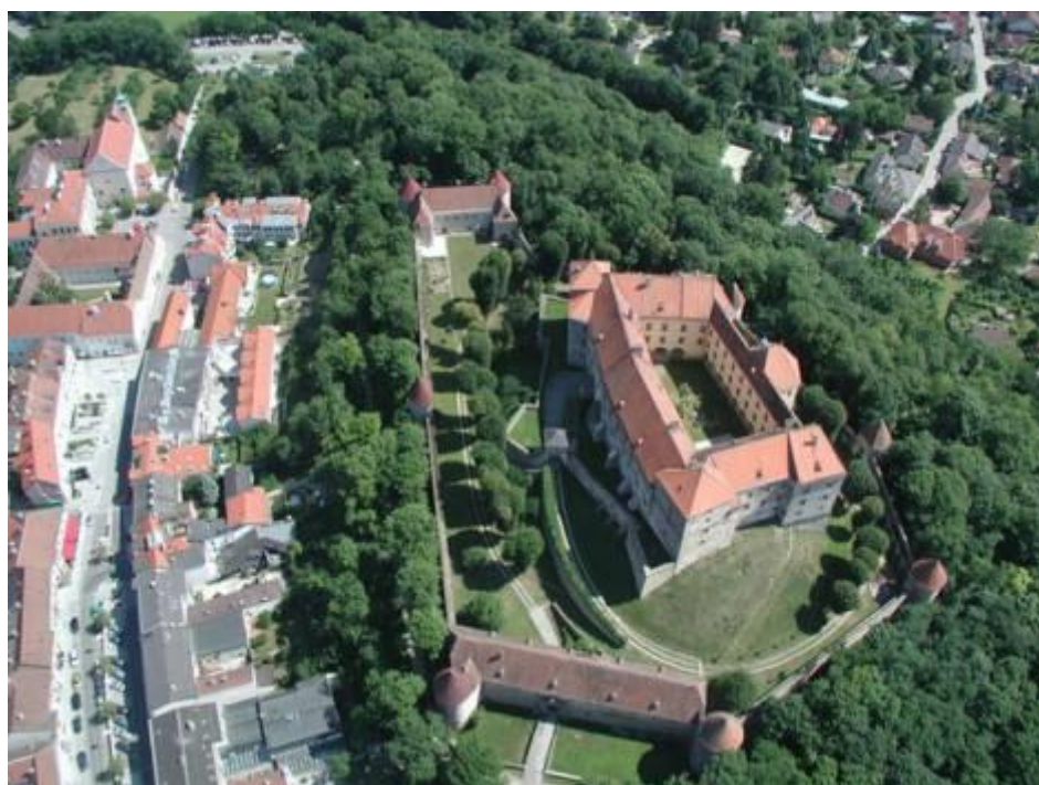
Abb. 59: Burg Neulengbach heute (im Vordergrund das Vorwerk, in der Bildmitte die Hochburg, im Hintergrund das Schloß umgeben von der Burgmauer und dem Schlosswald) 108
