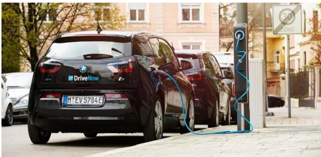
ABBILDUNG 72: STROMTANKSTELLE AN DER STRAßENLATERNE: SYSTEM "LIGHT & CHARGE" 130
