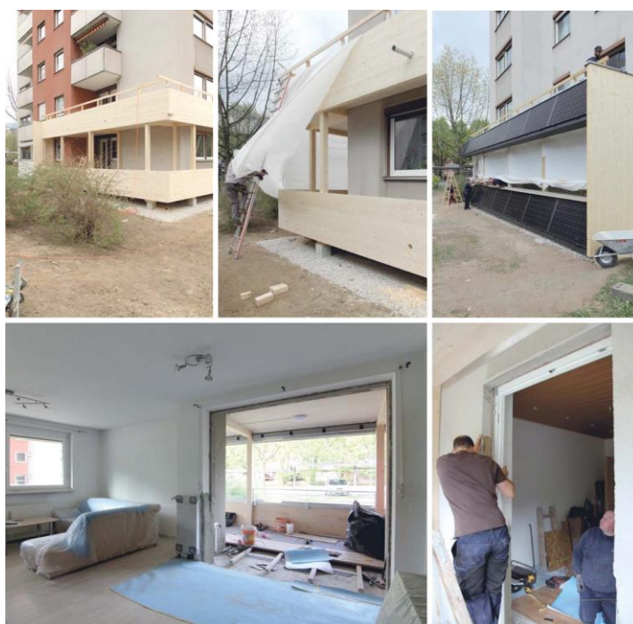
Abb. 26: Baufortschritt bzw. einzelne Arbeitsschritte am Demonstrationsmodul
