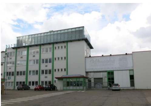
Abbildung 2: Ehemalige Wurstfabrik in Hemelingen. Jetzt die Wurst Case. Foto: ZZZ
