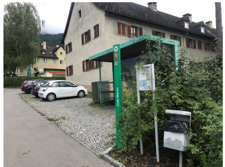
Abbildung 64: Bushaltestelle Meranerstraße (eigene Aufnahme)
