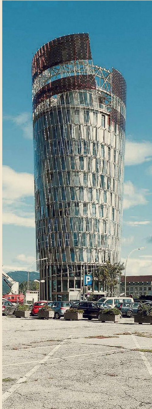
Projektinitiator und Architekt Pernthaler: „Der Science Tower ist mit den neuesten Systemen und Technologien ausgestattet.“
