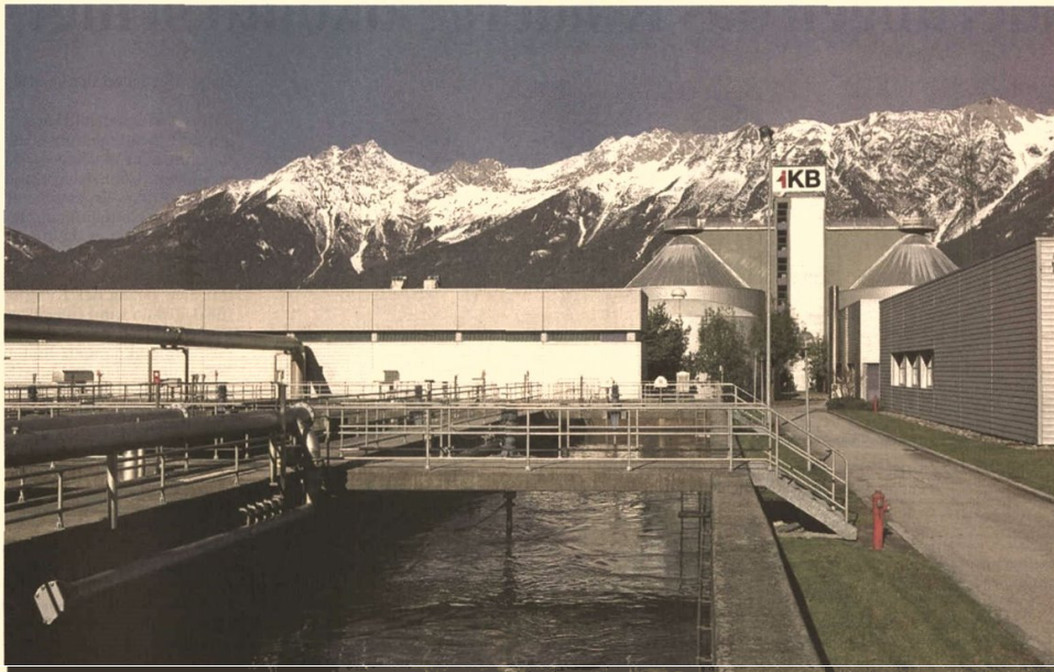
Vom Energiefresser zum Energielieferanten : Die Innsbrucker Kläranlage wurde mit einer Photovoltaikanlage , einem Holzgaskraftwerk und Technik zur energetischen Nutzung von Abwasser , Bioabfällen sowie Biomasse aufgerüstet.
