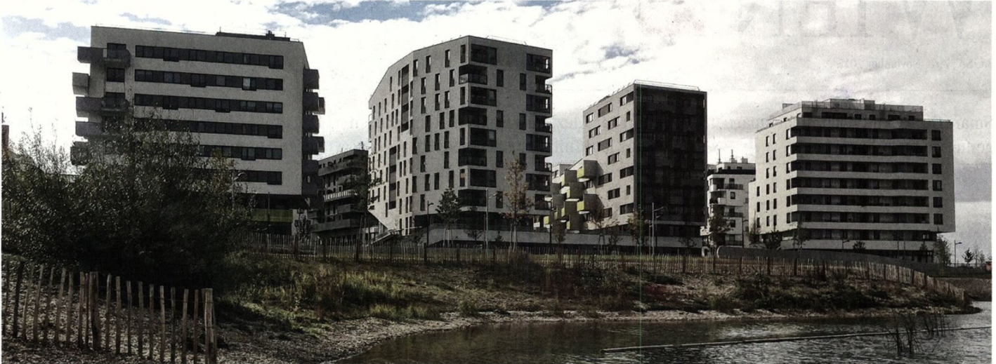
Während die Wohnhäuser im Süden der Seestadt mit Fernwärme ausgestattet sind (Foto), soll im Norden teilweise mit Gas geheizt werden, kritisieren Experten. Foto: W. Cenkl
