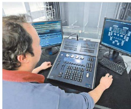
Der Regieraum ist für alle Arten von Veranstaltungen gerüstet.
