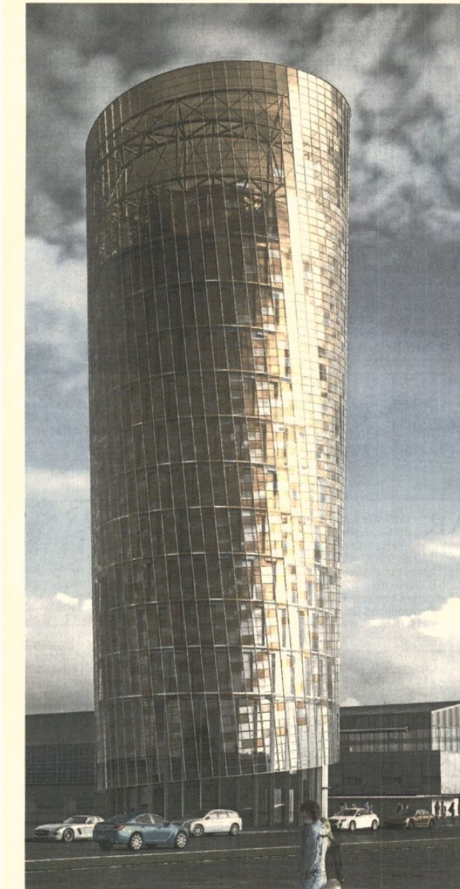
60 Meter hohe Beispielwirkung: Am Science Tower der Smart City Graz wird schon gebaut. Die letzten drei Stockwerke sind Garten.
